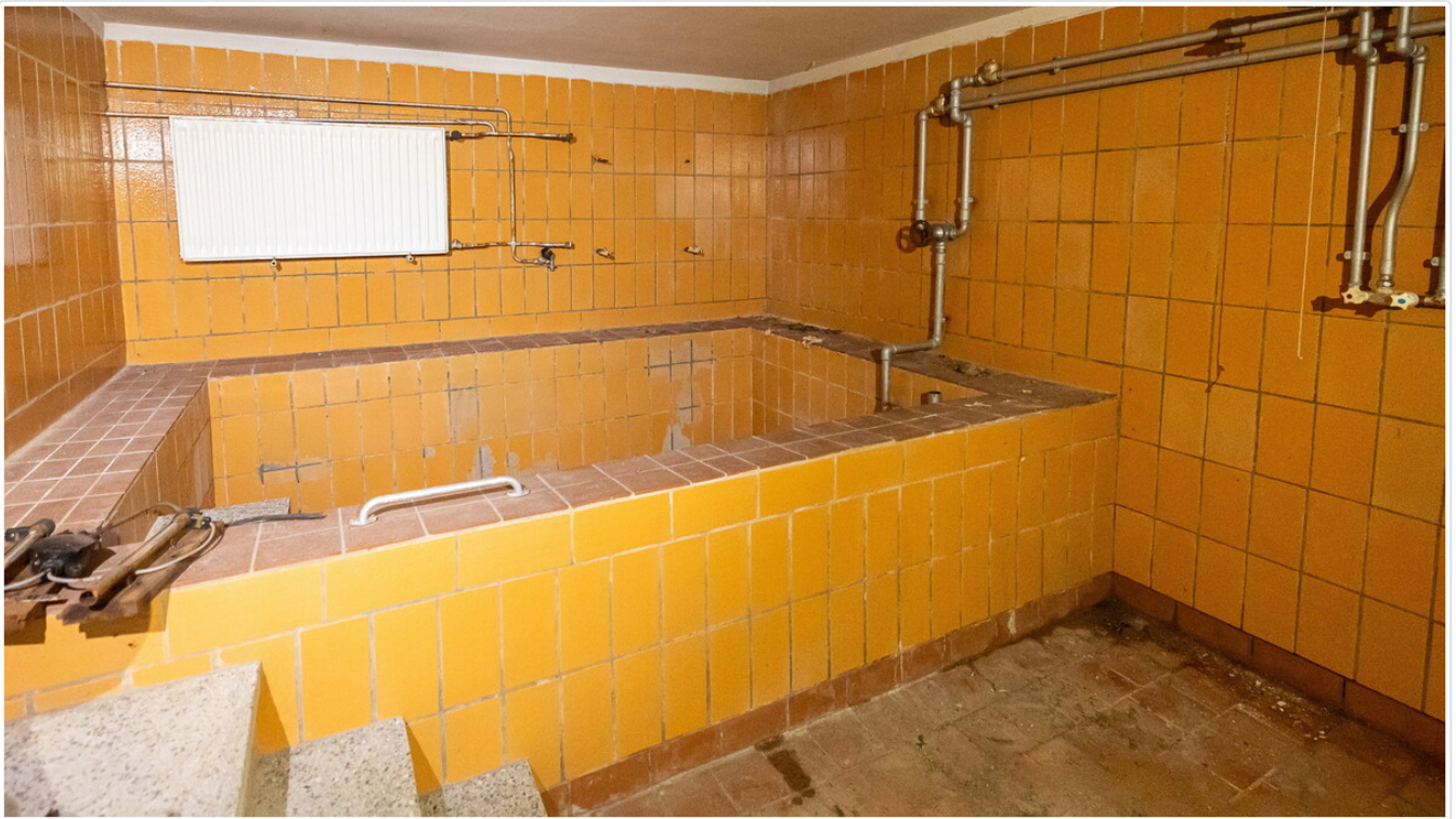
Wellness in Gelb: Die Fliesen im einstigen Saunabereich im Keller der Heymannbaude. © Karl-Ludwig Oberthür
