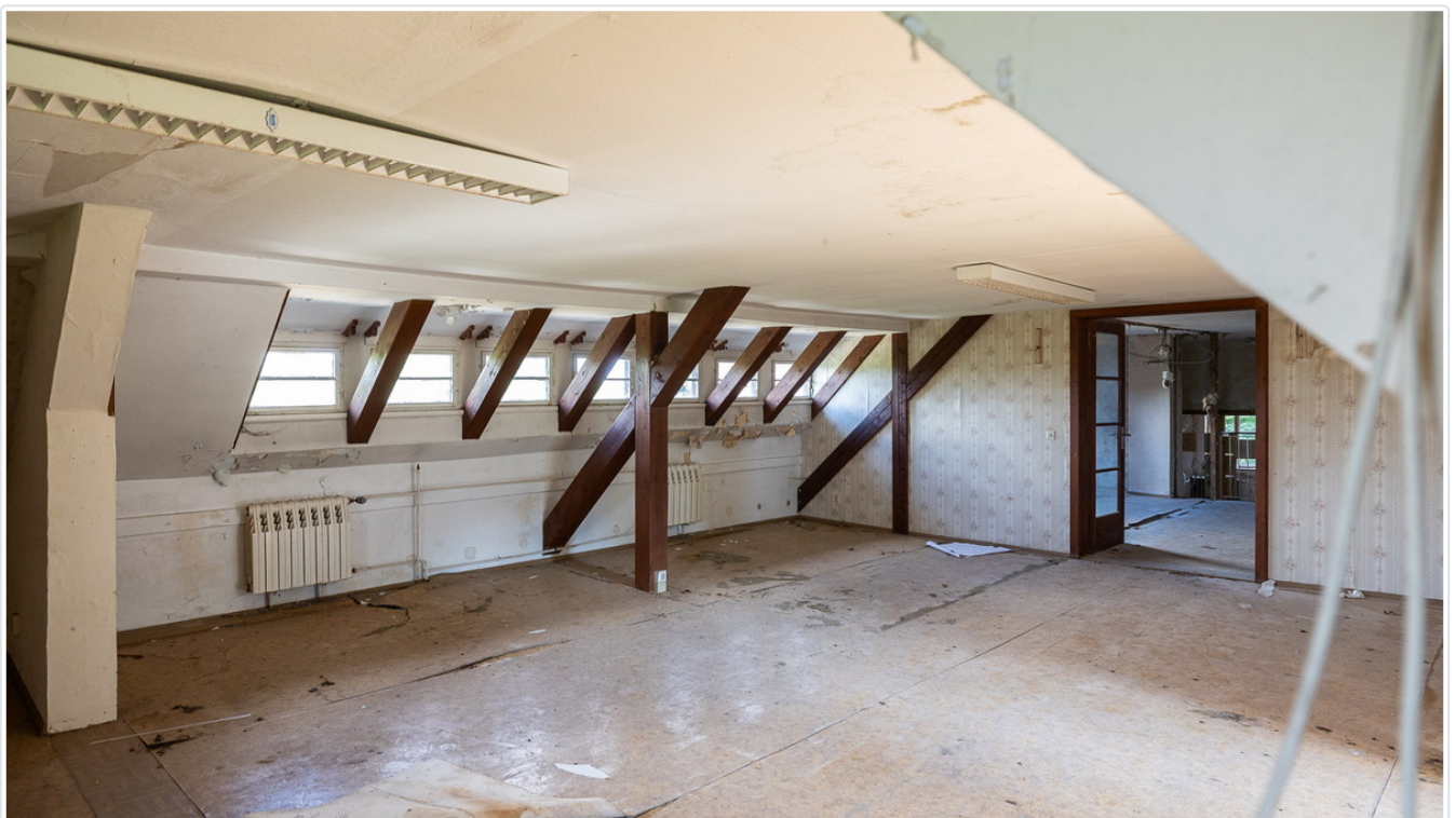
Früher Essensraum, künftig ein multifunktionaler Seminarraum. Über dem Saal der Heymannbaude sollen einmal Workshops und Seminare stattfinden. © Karl-Ludwig Oberthür
